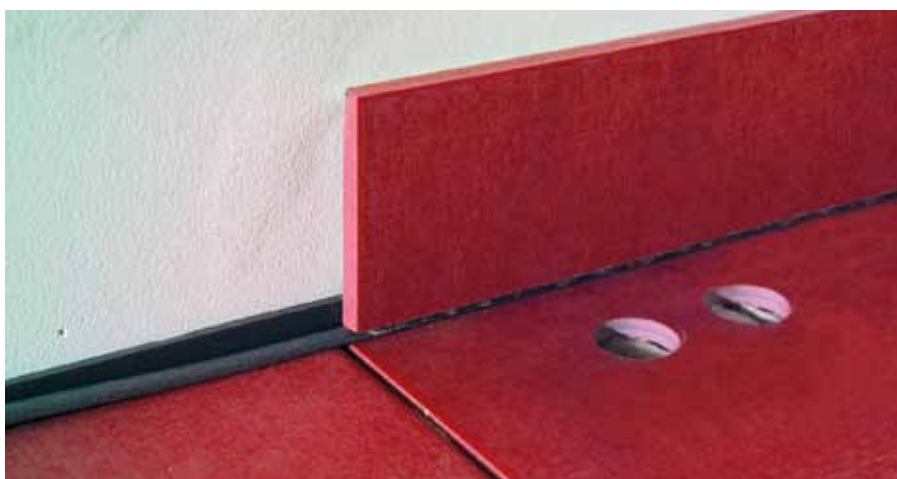
Obr. 12 Dilatační rohová spára
