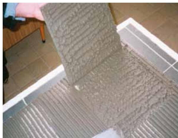
Obr. 6 – Lepení metodou Buttering-Floating
